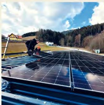
Die neue Parkplatzüberdachung kommt bei unseren Gästen sehr gut an. Mit der Errichtung einer Photovoltaikanlage auf der Dachfläche wird zusätzlich eine umweltfreundliche Energiegewinnung ermöglicht. 157 Photovoltaikplatten mit einer Leistung von 66 kwp tragen zur Verbesserung unseres ökologischen Fußabdrucks bei. Die Einbindung von regionalen Betrieben war uns wichtig. Besonders bedanken wir uns bei allen Beteiligten für die reibungslose und zeitgerechte Abwicklung!
